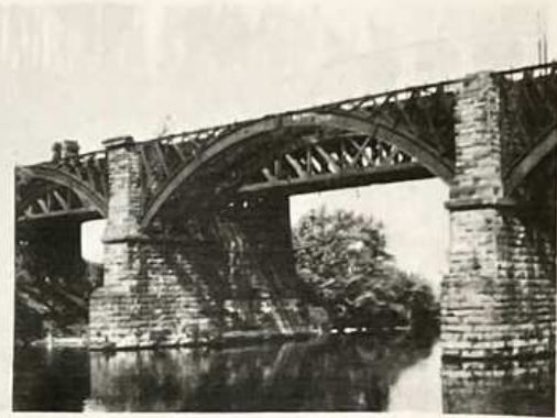
Fig. 24. Uddingston Viaduct (NS 688608)
