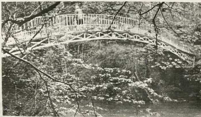
Fig. 23. Duchess Bridge, Langholm (NY 356853)
