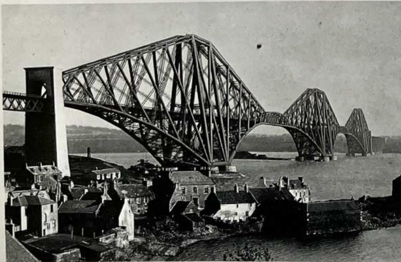
Pont sur le Forth.
