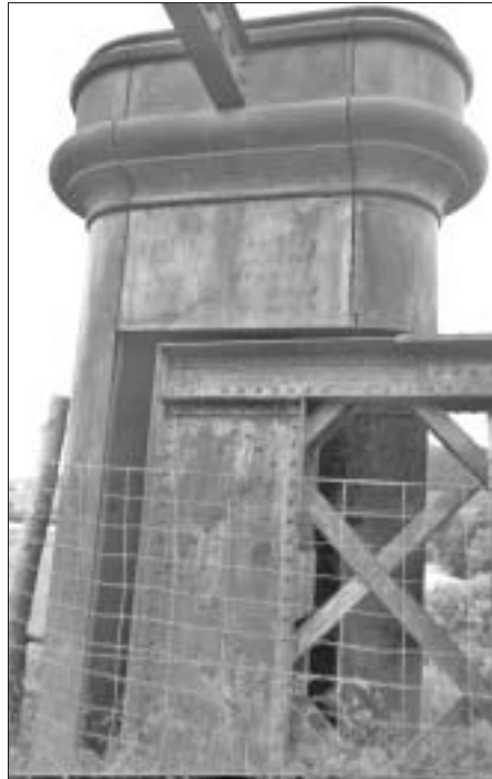
Logierait Viaduct – iron tower
