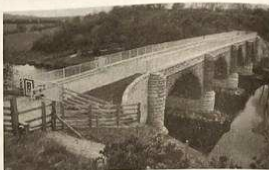
写真 1-8 保全工事終了後の高架橋全景（北側より）
