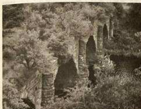
写真1-9 保全工事前的高架橋全景(南側より)
