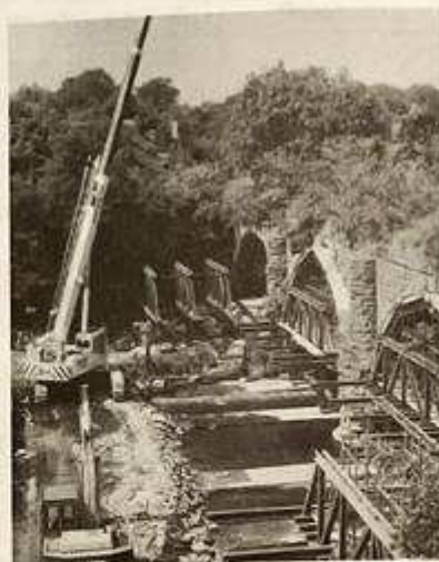
写真1-11 保全工事着工直後(1995.8.3) 仮堰堤が設置され、川床にRCはりが設置され鋼製支保工が組み立てられている。
