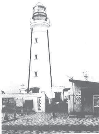
写真66-1 現在の犬吠埼灯台 (1997年)
