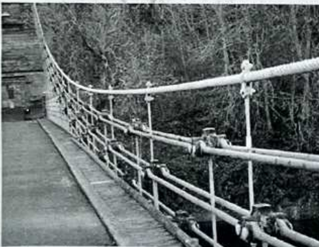
図-6 1902年にチェーンケーブルの上に追加されたワイヤーケーブル(2014.11)
