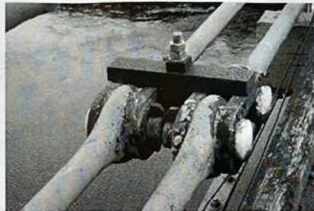
図-7 オリジナルのハンガー定着部(上)と応急処置のハンガー(2014.11)
