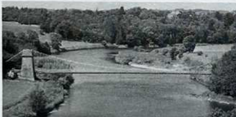
図-1 ユニオン吊橋全景(2013.4)
