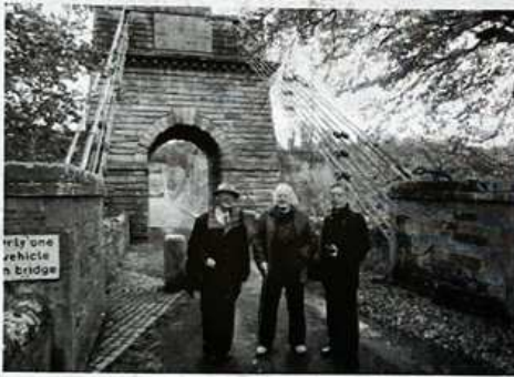
図-5 左岸(スコットランド)側の石造の塔とアンカレッジ(2014.11)
